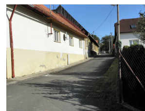
Obnova místní komunikace Druhá strana v obci Podolí
