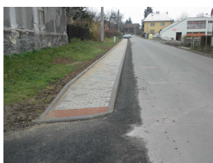
Oprava chodníku v lokalitě "Pivovárka" v obci Loučka
